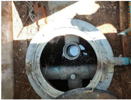
บ่อกักน้ำทิ้งก่อนเข้าสู่ระบบบำบัดน้ำเสีย ของอาคารที่พักผู้โดยสาร ชุดที่ 2
