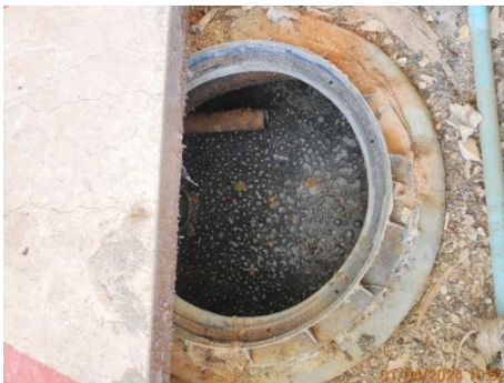
บ่อกักน้ำทิ้งก่อนเข้าสู่ระบบบำบัดน้ำเสีย ของอาคารที่พักผู้โดยสาร ชุดที่ 3
