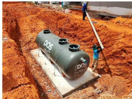
กิจกรรมการก่อสร้างระบบบำบัดน้ำเสีย ของอาคารคลังสินค้า
