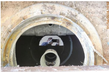
บ่อกักน้ำทิ้งก่อนเข้าสู่ระบบบำบัดน้ำเสีย ของอาคารที่พักผู้โดยสาร ชุดที่ 3
