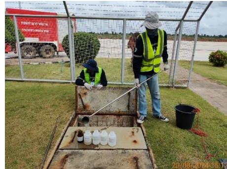
บ่อบำบัดน้ำทิ้งหลังผ่านระบบบำบัดน้ำเสีย ของอาคารที่พักผู้โดยสาร ชุดที่ 4
