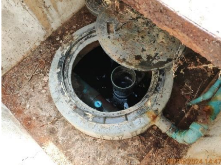
บ่อบำบัดน้ำทิ้งหลังผ่านระบบบำบัดน้ำเสีย ของอาคารที่พักผู้โดยสาร ชุดที่ 2
