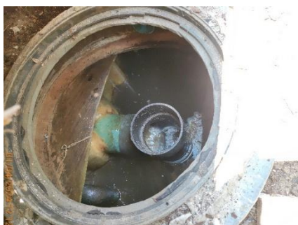
บ่อกักน้ำทิ้งก่อนเข้าสู่ระบบบำบัดน้ำเสีย ของอาคารที่พักผู้โดยสาร ชุดที่ 1
