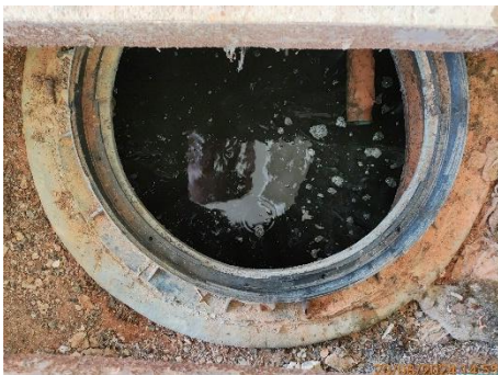
บ่อบำบัดน้ำทิ้งก่อนเข้าสู่ระบบบำบัดน้ำเสีย ของอาคารที่พักผู้โดยสาร ชุดที่ 3
