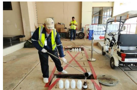
บ่อกักน้ำทิ้งก่อนเข้าสู่ระบบบำบัดน้ำเสีย ของอาคารที่พักผู้โดยสาร ชุดที่ 3
