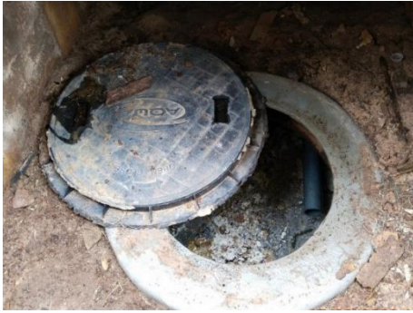
บ่อกักน้ำทิ้งก่อนเข้าสู่ระบบบำบัดน้ำเสีย ของอาคารที่พักผู้โดยสาร ชุดที่ 4
