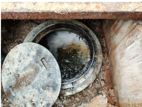
บ่อกักน้ำทิ้งหลังผ่านระบบบำบัดน้ำเสีย ของอาคารที่พักผู้โดยสาร ชุดที่ 1
