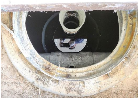
บ่อบำบัดน้ำทิ้งหลังผ่านระบบบำบัดน้ำเสีย ของอาคารที่พักผู้โดยสาร ชุดที่ 3
